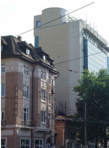
Aceeași clădire, după de-placarea fațadei vestice (foto: Ana-Maria Dabija)
