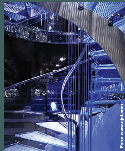
Scară în spirală, cu trepte din sticlă susținute de tiranți metalici. Arhitect Eva Jiricna Architects, 2008. Galerie de bijuterii, Muzeul Victoria & Albert, Londra, Anglia. (Foto: Katsuhisa Kida)
