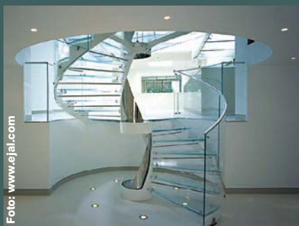
Scară circulară cu structură metalică sculpturală și trepte din sticlă. Arhitect Eva Jiricna Architects. Locuință în Belgravia, Londra, Anglia. (Foto: Richard Bryant, Arcaid)
