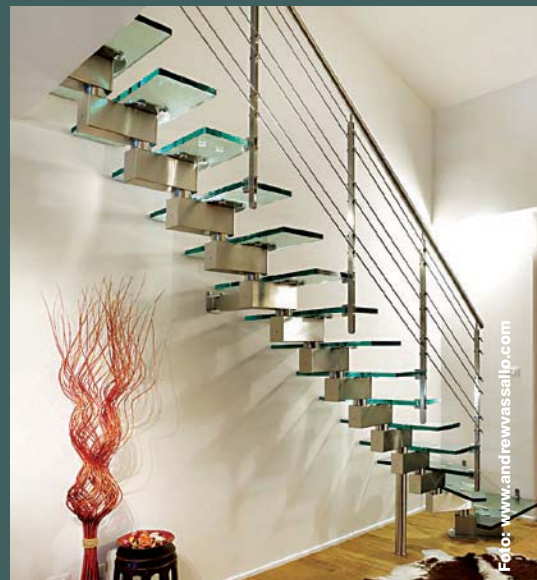
Scară cu structură din oțel inox și trepte din sticlă
