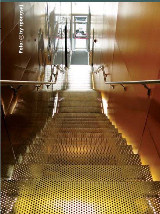
Scară cu trepte din tablă perforată. Muzeul Institutului de Tehnologie Massachusetts. Cambridge, Massachusetts, SUA
