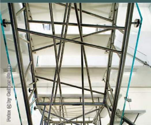
Genetic Stair, scară metalică cu structură din grinzi cu zăbrele din oțel inox. Design, execuție și instalare Caliper Studio (Photo © Ty Cole, 2009)
