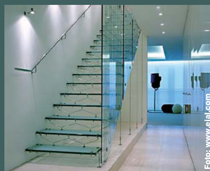
Scară cu trepte din sticlă susținute o structură metalică subțire, cu tiranți. Arhitect Eva Jiricna Architects, 2002. Apartament penthouse, Londra, Anglia. (Foto: Richard Bryant, Arcaid)
