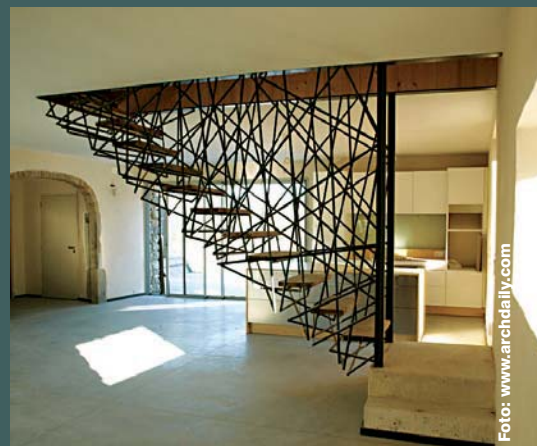
Scară suspendată pe structură metalică din bare de oțel. Arhitect Atelier Archiplein, renovare 2009. Casa Roche, Rochebaudin, Franța
