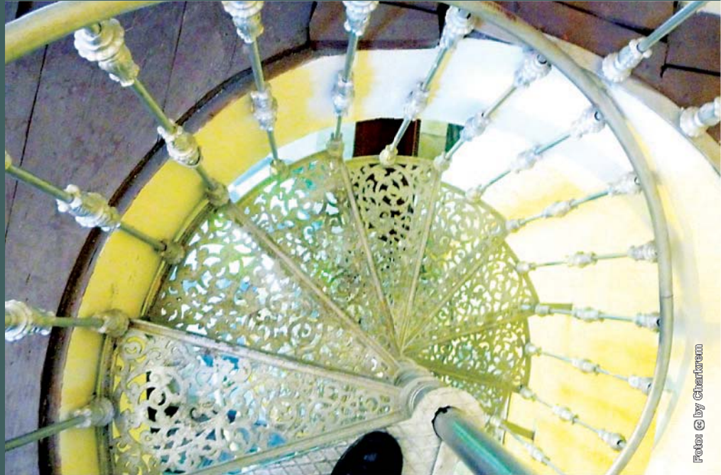
Scară metalică în spirală, cu trepte perforate, în Capela Mănăstirii catolice Chijmes, 1904. Singapore
