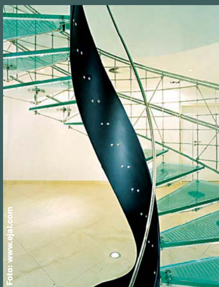
Scară în spirală, cu structură metalică și trepte din sticlă. Arhitect Eva Jiricna Architects. Hotel Josef, Praga, Cehia. (Foto: Ivan Nemeč)
