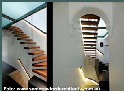
Scară cu trepte susținute de tiranți metalici. Arhitecți Sam Crawford Architects, 2009. Casa Newtown Terrace, Australia. (Foto: Brett Boardman)
