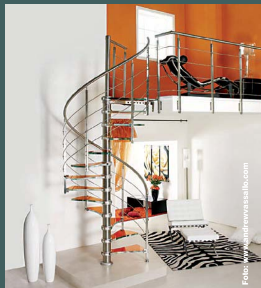
Scară metalică în spirală din oțel inox
