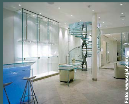
Scară în spirală cu structură metalică și trepte din sticlă. Arhitect Eva Jiricna Architects, 2004. Magazinul Boodles, Londra, Anglia. (Foto: Richard Bryant, Arcaid)
