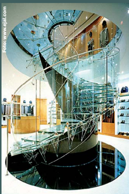
Scară în spirală, cu trepte din sticlă și structură din tiranți metalici. Arhitect Eva Jiricna Architects, 1994. Magazinul de încălțăminte Joan & David, Londra, Anglia. (Foto: Katsuhisa Kida)
