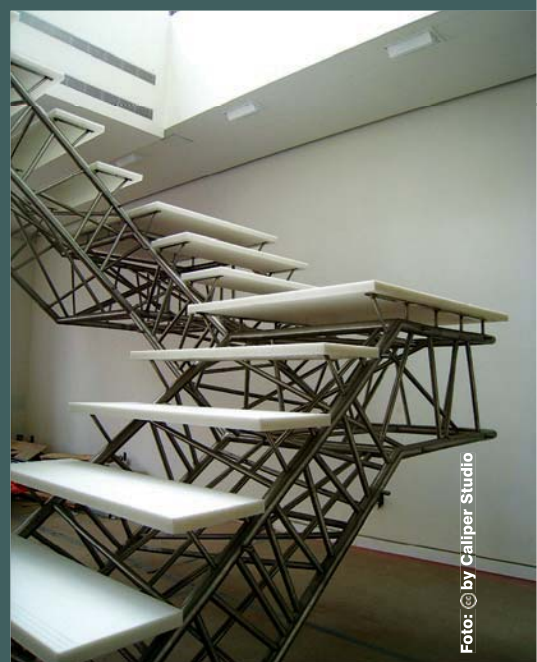
Genetic Stair, scară metalică cu structură din grinzi cu zăbrele din oțel inox. Design, execuție și instalare Caliper Studio
