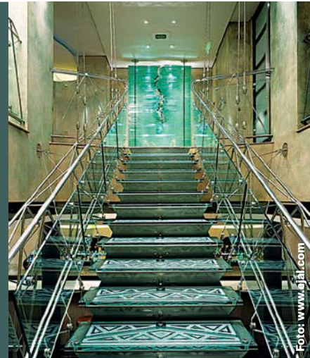
Scară într-o rampă, cu trepte din sticlă susținute de tiranți metalici. Arhitect Eva Jiricna Architects, 1991. Clubul de noapte Browns, Londra, Anglia. (Foto: Richard Bryant, Arcaid)
