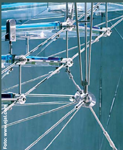
Scară într-o rampă, cu trepte din sticlă susținute de tiranți metalici. Arhitect Eva Jiricna Architects, 1989. Magazinul Joseph, Londra, Anglia. (Foto: Richard Bryant, Arcaid)
