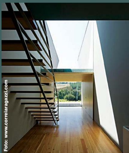
Scară cu trepte susținute de o grindă metalică cu rol și de balustradă. Arhitecți G. Correia și R. Ragazzi, 2008. Casa Em, Lousado, Portugalia. (Foto: Alberto Placido, Luis Ferreira Alves)
