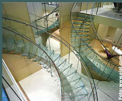
Scări circulare cu trepte din sticlă și structură metalică (vang central și tiranți). Arhitect Eva Jiricna Architects, 2008. Magazinul de bijuterii Boodles, Londra, Anglia. (Foto: Richard Bryant, Arcaid)
