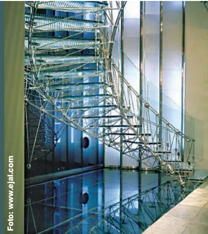
Scară circulară cu trepte din sticlă, pe structură din grinzi metalice cu zăbrele și tiranți. Arhitect Eva Jiricna Architects, 1994. Apartament duplex în Londra, Anglia. (Foto: Richard Bryant, Arcaid)
