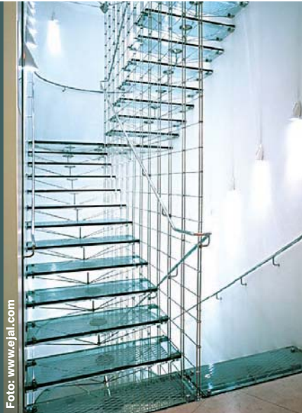
Scară în două rampe, cu trepte din sticlă susținute de tiranți metalici. Arhitect Eva Jiricna Architects, 2002. Sediul Amec, Londra, Anglia. (Foto: Richard Bryant, Arcaid)
