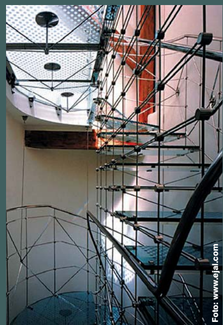
Scară cu trepte din sticlă, suspendată cu tiranți metalici. Arhitect Eva Jiricna Architects, 1999. Reconversia unui loft într-o clădire istorică, Praga, Cehia. (Foto: Richard Bryant, Arcaid)
