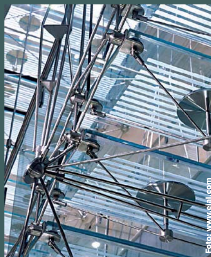
Scară într-o rampă, cu trepte din sticlă susținute de tiranți metalici. Arhitect Eva Jiricna Architects, 1989. Magazinul Joseph, Londra, Anglia. (Foto: Richard Bryant, Arcaid)
