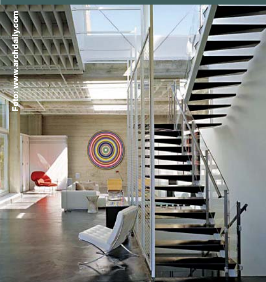
Scară metalică cu trepte în consolă pe grindă centrală. Arhitecți Fougerson Architecture, 2007. Locuință cu birou, San Francisco, California, SUA (Foto: Richard Barnes & Rien Van Rijnthoven)
