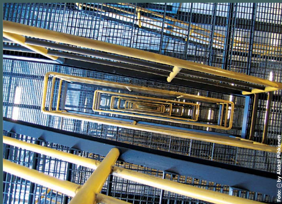
Scară metalică cu trepte în consolă pe grindă centrală. Arhitecți Fougerson Architecture, 2007. Locuință cu birou, San Francisco, California, SUA (Foto: Richard Barnes & Rien Van Rijnthoven)
