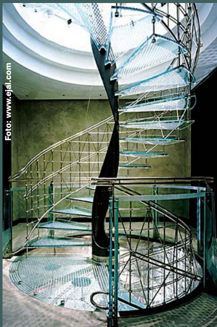
Scară în spirală, cu structură metalică ușoară și trepte din sticlă. Arhitect Eva Jiricna Architects, 1992. Apartament duplex în Londra, Anglia. (Foto: Richard Bryant, Arcaid)
