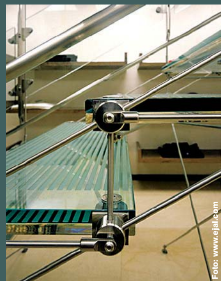
Scară într-o rampă, cu trepte din sticlă susținute de tiranți metalici. Arhitect Eva Jiricna Architects, 1989. Magazinul Joseph, Londra, Anglia. (Foto: Peter Cook, View)
