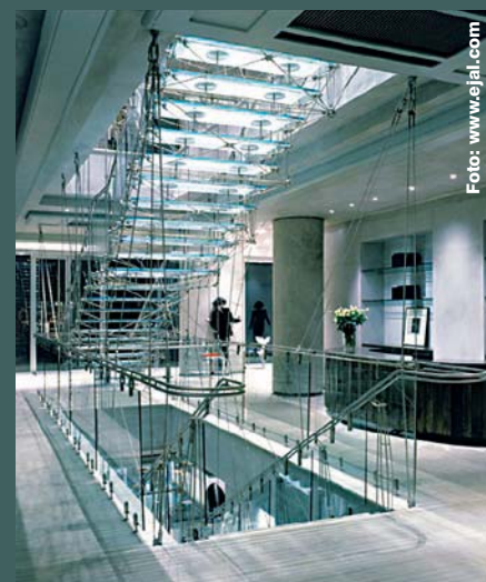
Scară într-o rampă, cu trepte din sticlă susținute de tiranți metalici. Arhitect Eva Jiricna Architects, 1989. Magazinul Joseph, Londra, Anglia. (Foto: Richard Bryant, Arcaid)
