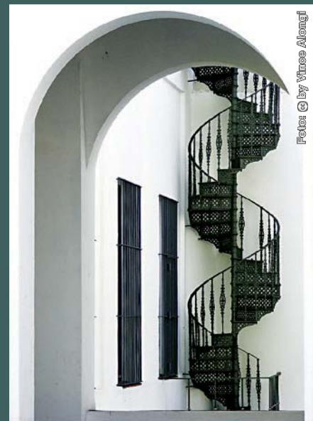
Scară metalică spiralată cu trepte perforate. Montevideo, Uruguay
