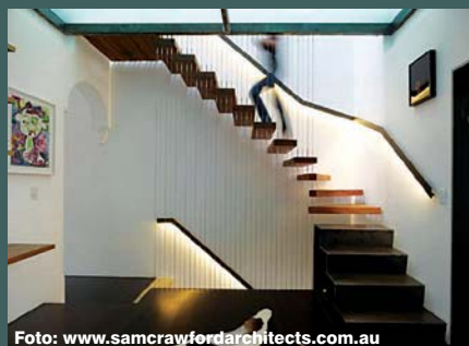
Scară cu trepte susținute de tiranți metalici. Arhitecți Sam Crawford Architects, 2009. Casa Newtown Terrace, Australia. (Foto: Brett Boardman)
